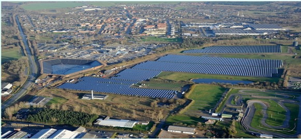
Beispiel: Anlage bei Vojens (Dänemark) im Bau. Links der vorbereitete Saisonspeicher. [48]
